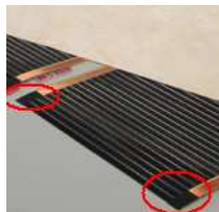
Koperen eindstukken isoleren met ducttape of PVC tape
